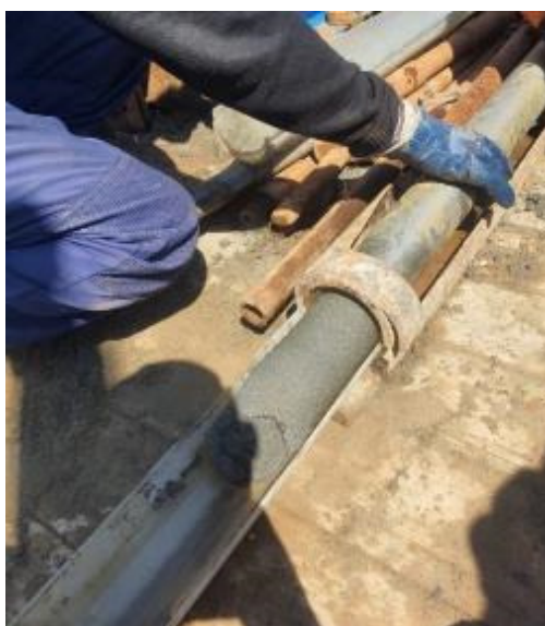
Рисунок 4.2 – Извлечение керна при помощи экструдера
